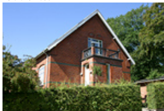
Områdets gamle villaer har ofte flotte bygningsdetaljer.
