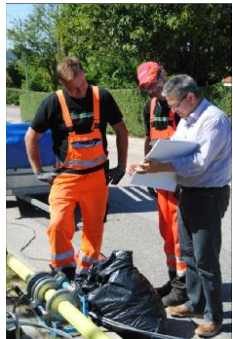
Figur 2 Renovering af ledningsnet i Hasseris i 2013. Arbejdet planlægges i fællesskab (Foto: Astrid Melkær for Aalborg Forsyning, Gas).
