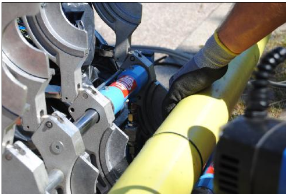
Figur 1 Ledningsrenovering (plastsvejsning) i Hasseris i 2013 (Foto: Astrid Melkær for Aalborg Forsyning, Gas)
