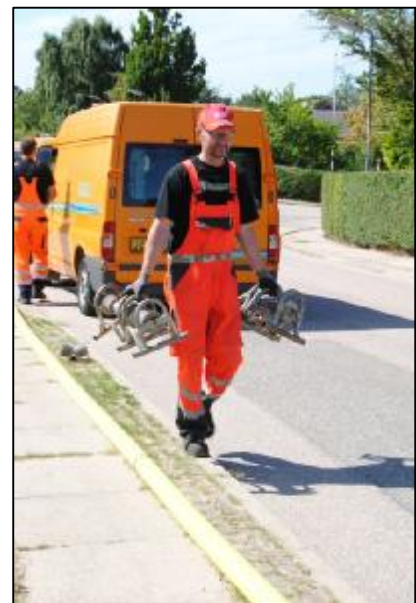
Figur 3 Ledningsreovering i Hasseris i 2013 (Foto: Astrid Melkær for Aalborg Forsyning, Gas)
