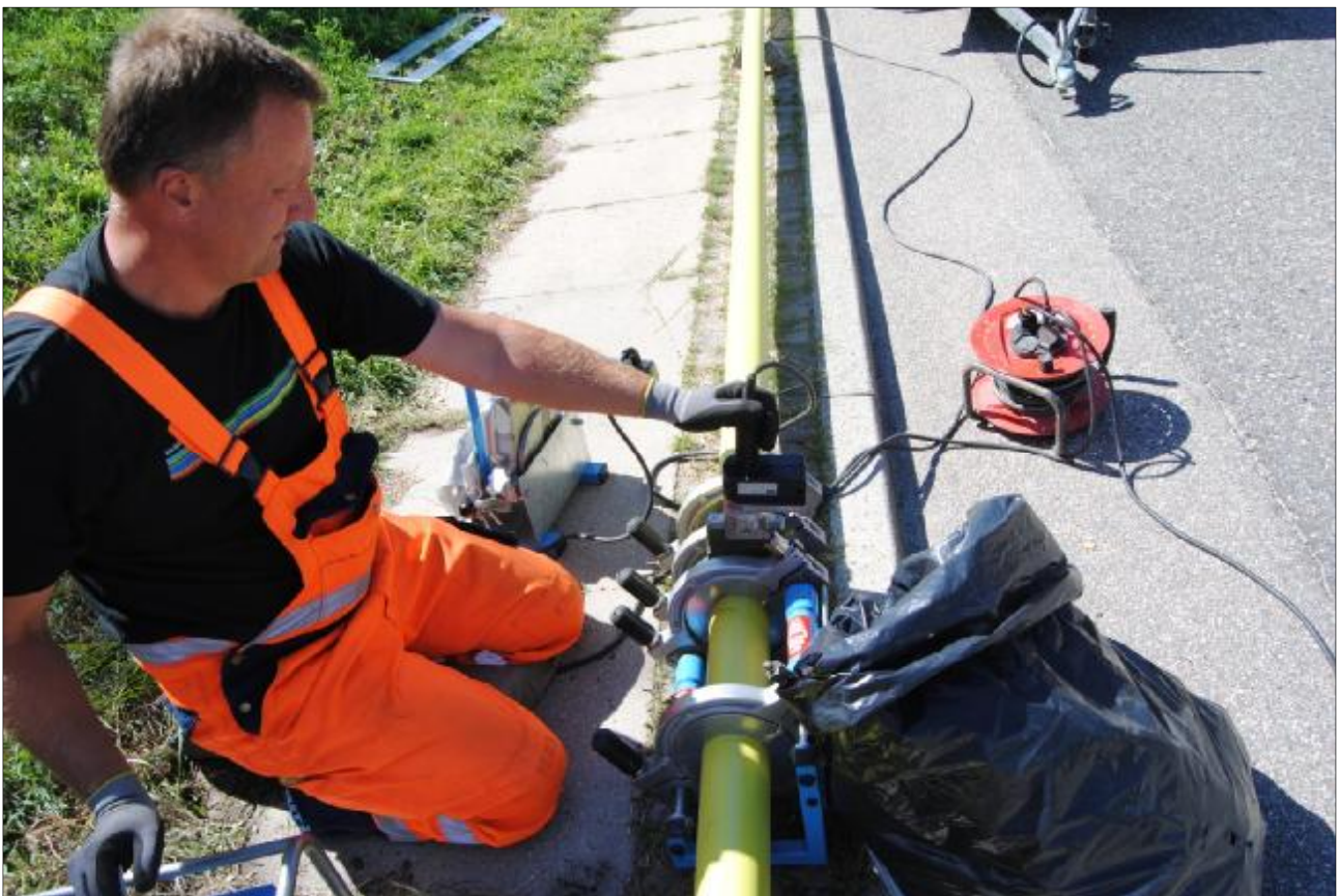
Figur 4 Ledningsrenovering i Hasseris 2013. Plastrørene svejses (Foto: Astrid Melkær for Aalborg Forsyning, Gas)
