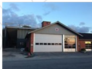
Opførelse af ny brandstation
