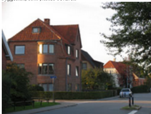
Der lægges vægt på at bevare "Kærbyhusenes" særlige karaktertræk: højtliggende kældre, høj trappe ved entrédøren, røde mursten, tegltage og afvalmede gavle.
