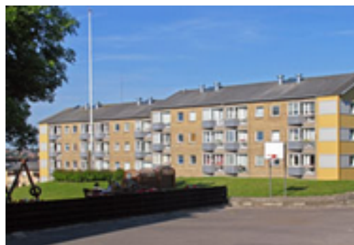
Etageboliger med store fælles friarealer.
