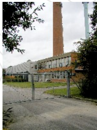
Varmecentralen på Vikingevej.
